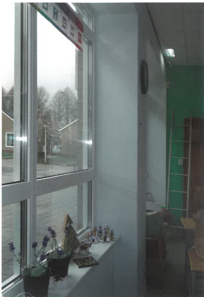
De dragende penanten in de gevel van schoon metselwerk zijn binnen geïsoleerd en wit afgewerkt.
