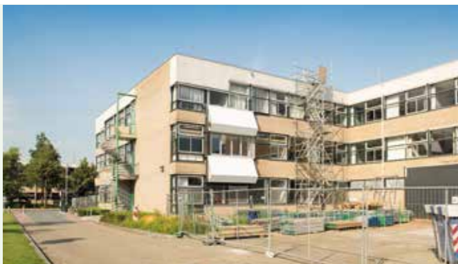
Gevelrenovatie in uitvoering.
