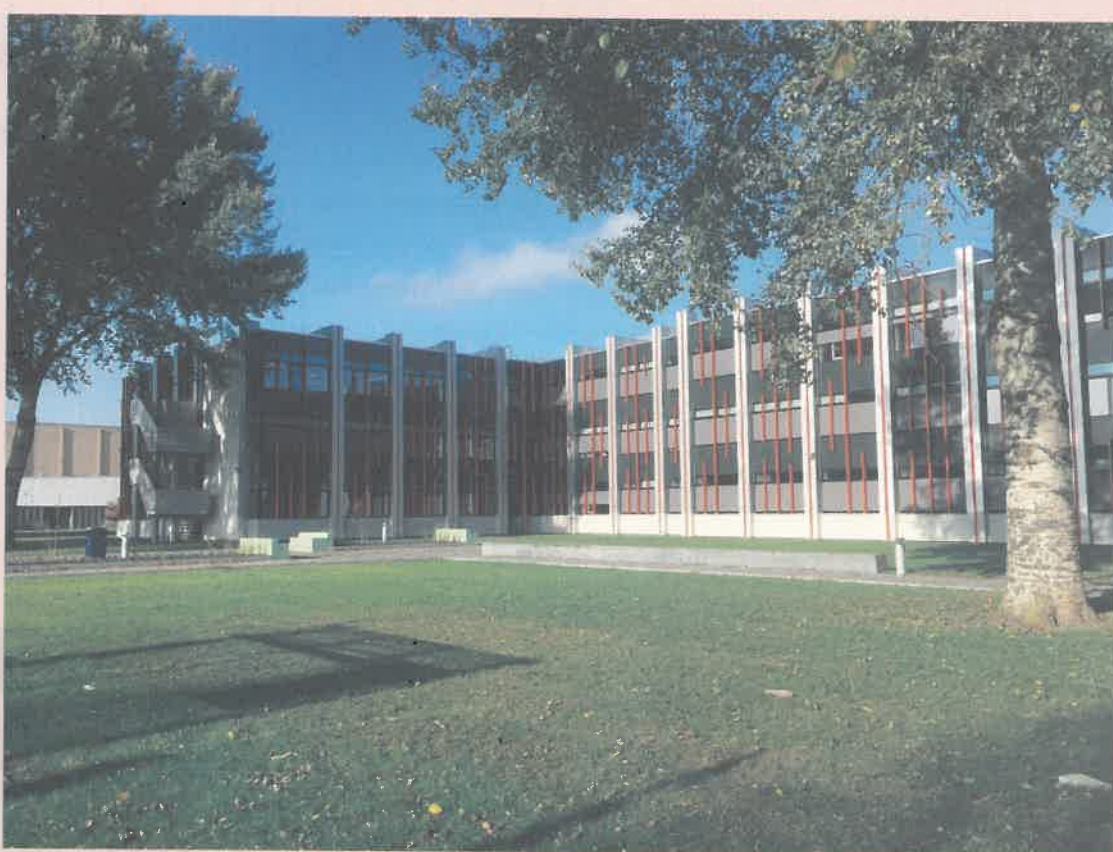
In gebouw A, dat twee jaar geleden is gerenoveerd, is eveneens de installatietechniek in de gevel verwerkt. Hier is dat echter in verticale banen verwerkt. (Foto: Hogeschool Windesheim)
